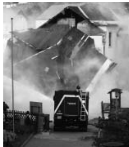
Abriss der Grundschule Schmiedeberg
